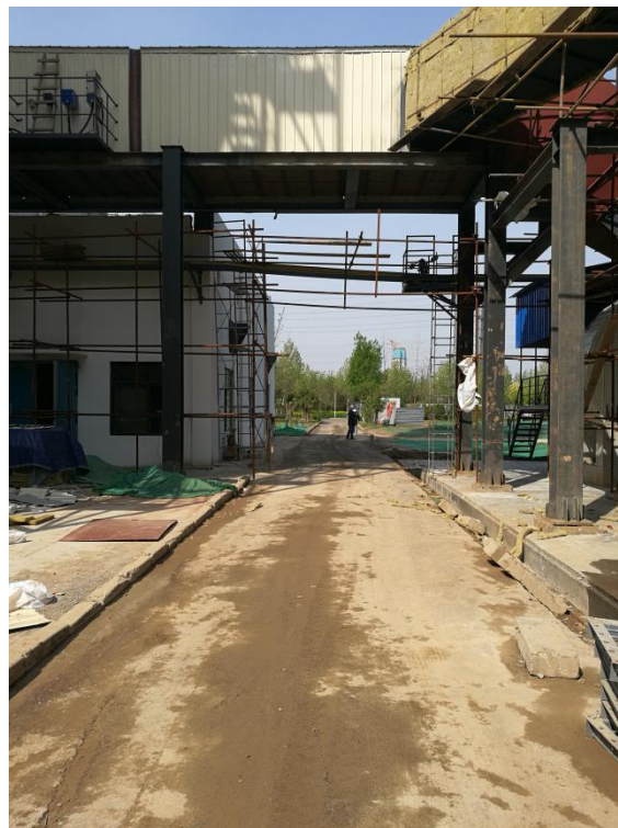
在建工程建设现场
