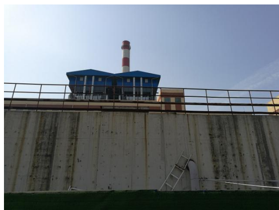
原水池+软水池
