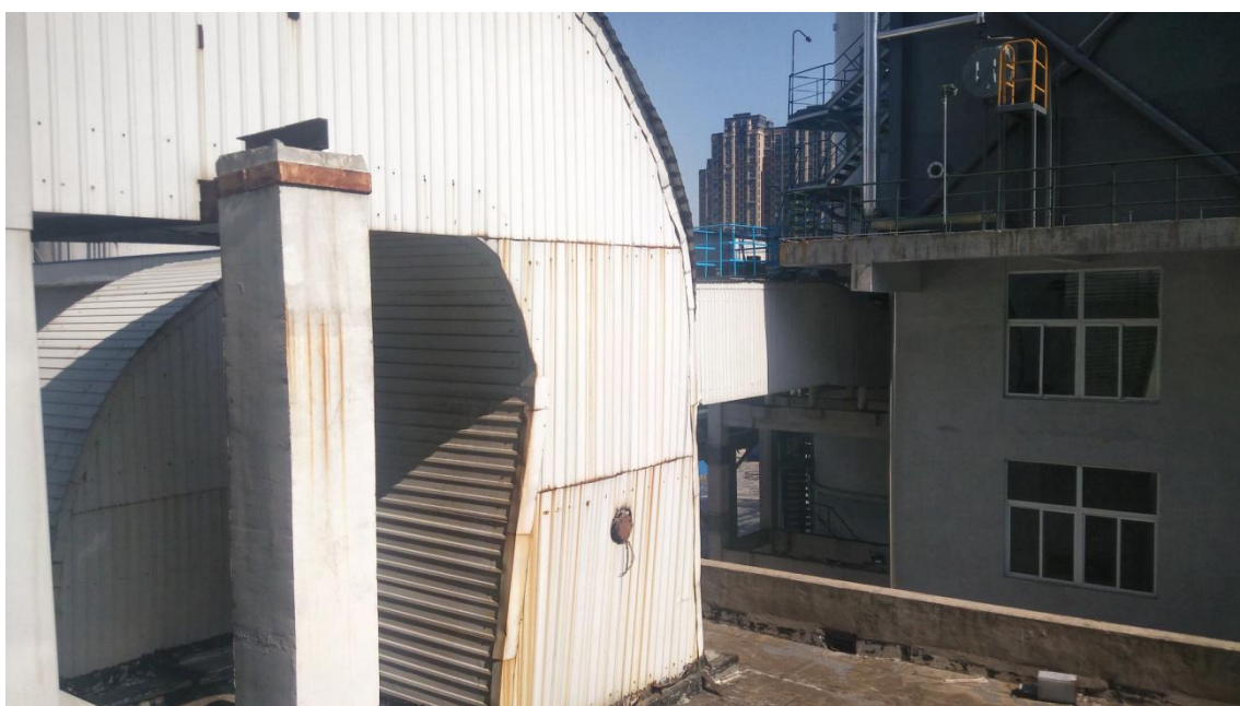
图 5-6 7#锅炉脱硫后、湿电前检测口
