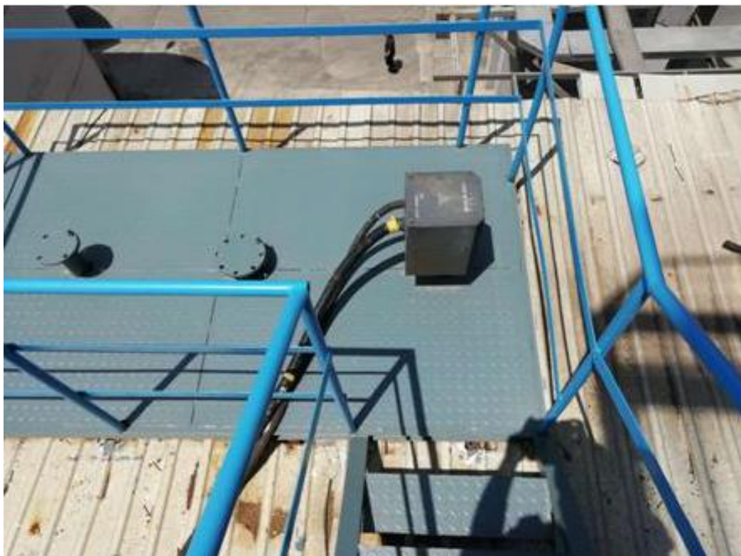
图 5-6 7#锅炉脱硫后、湿电前检测口
