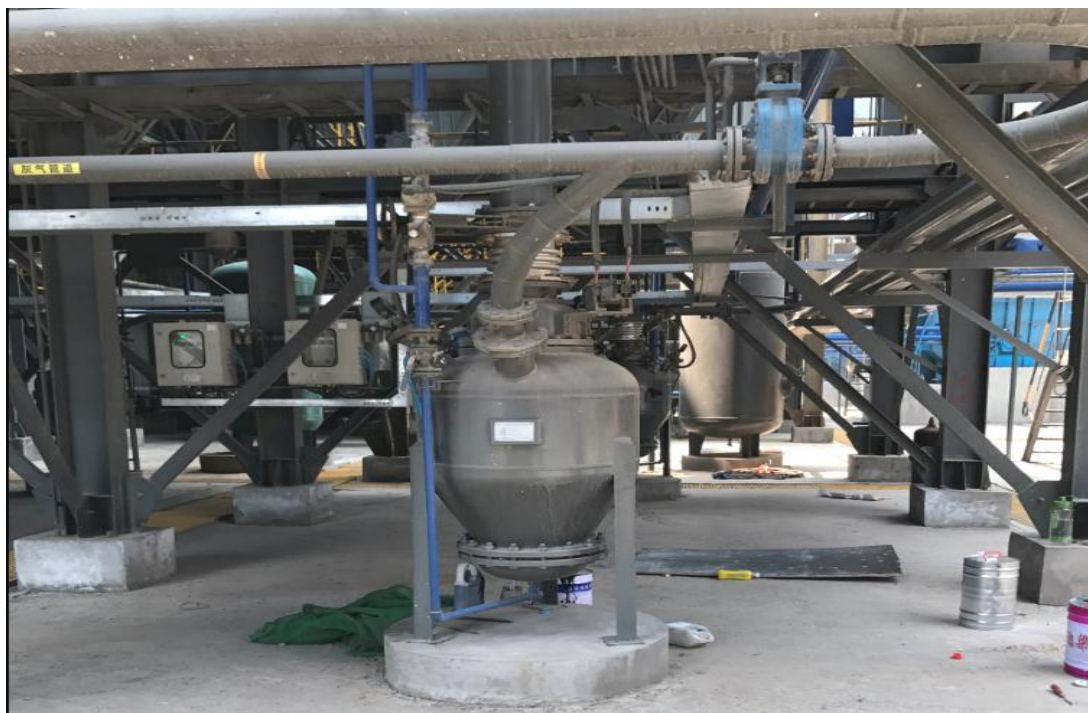
图 2-17 项目气力输灰装置
