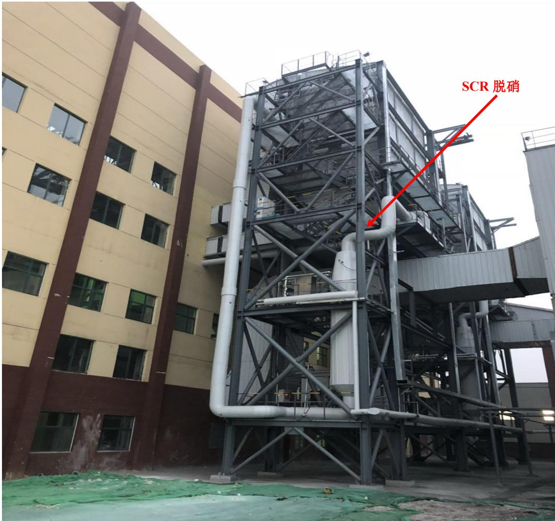
图 2-10 SCR 脱硝系统
